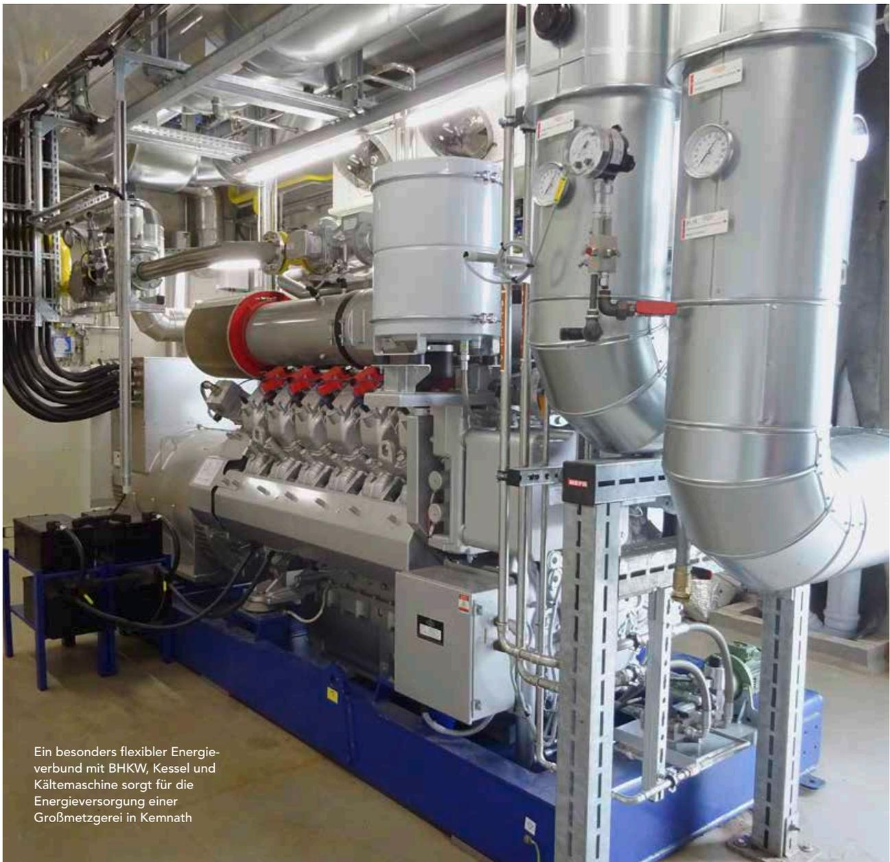
Ein besonders flexibler Energieverbund mit BHKW, Kessel und Kältemaschine sorgt für die Energieversorgung einer Großmetzgerei in Kemnath
